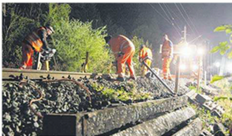
Nächtlicher Einsatz auf den Gleisen der Montafonerbahn für noch mehr Sicherheit entlang der Bahnlinie. FOTO: MEZNAR.MEDIA
