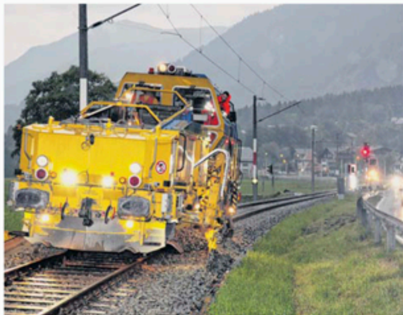
Spektakulärer Einsatz am Bahngleis: Wartungsarbeiten entlang der Montafonerbahnlinie mit einem Spezialzug. FOTO: MEZNAR-MEDIA.COM
