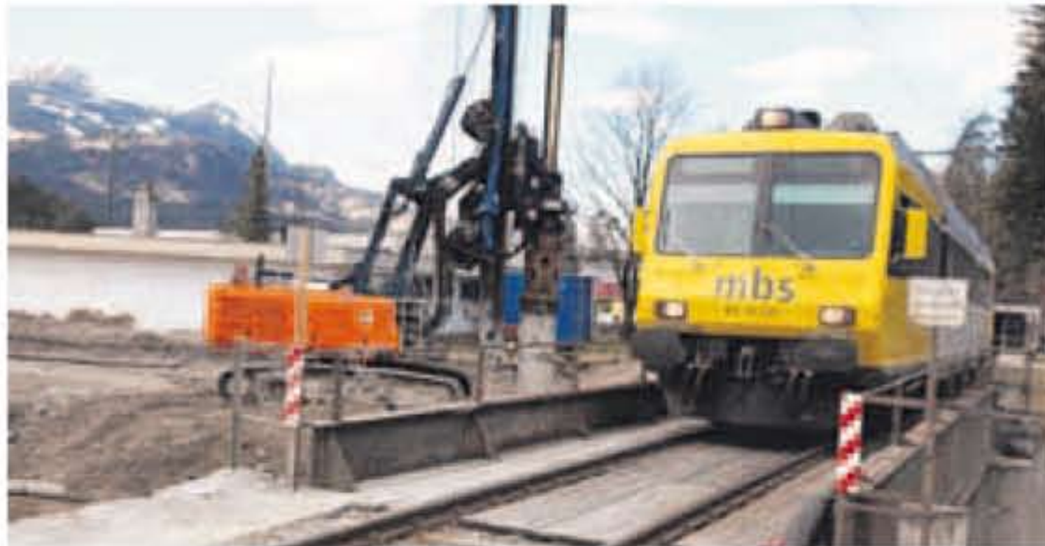
Die Bauarbeiten beim Trassenneubau der Montafonerbahn in Lorüns laufen auf Hochtouren.
