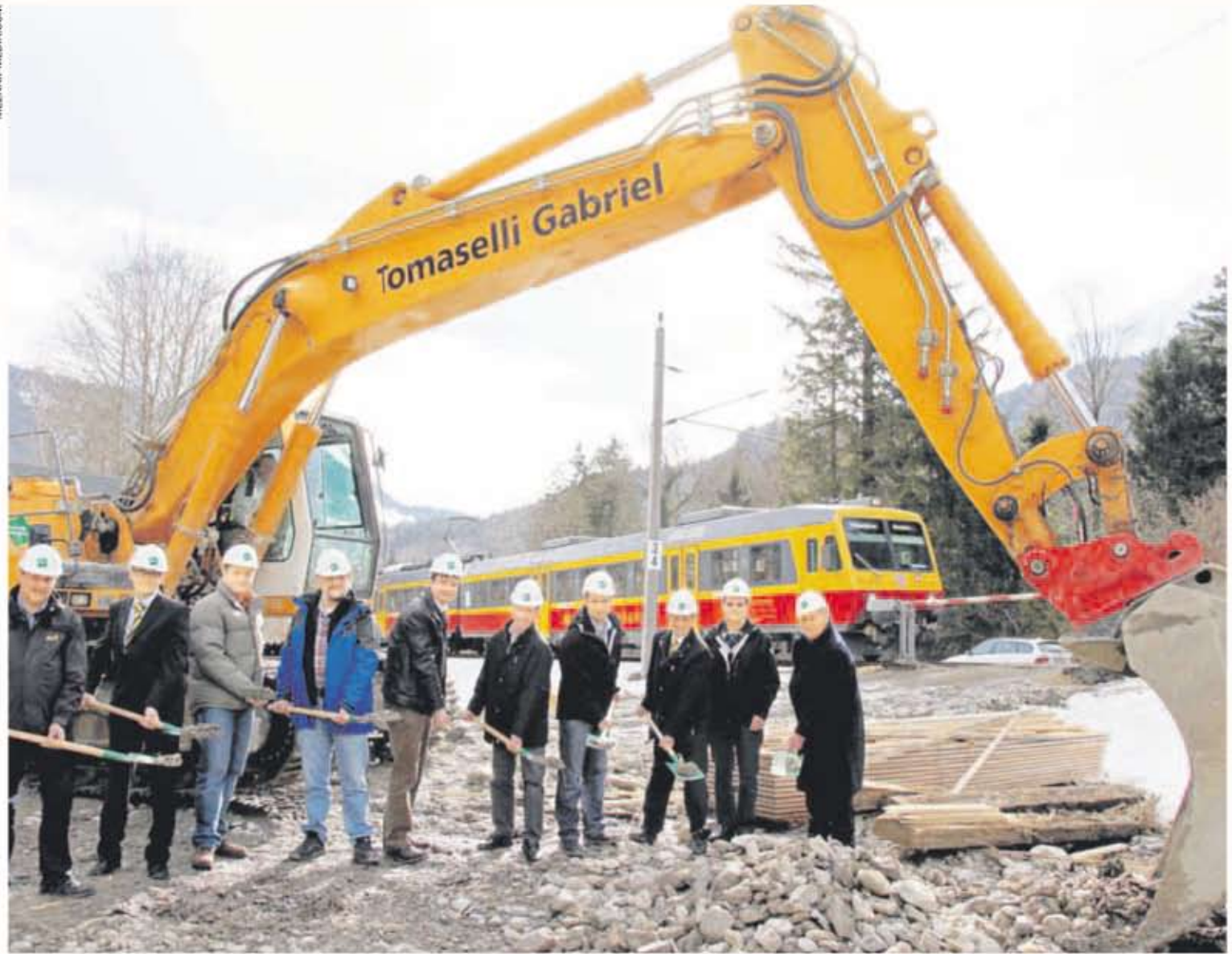
Der Spatenstich für den Bahntrassenbau im Bereich Lorüns mit dem Neubau der Alfenz- und Illbrücken ist erfolgt. Die Bagger sind schon ange- rollt.
