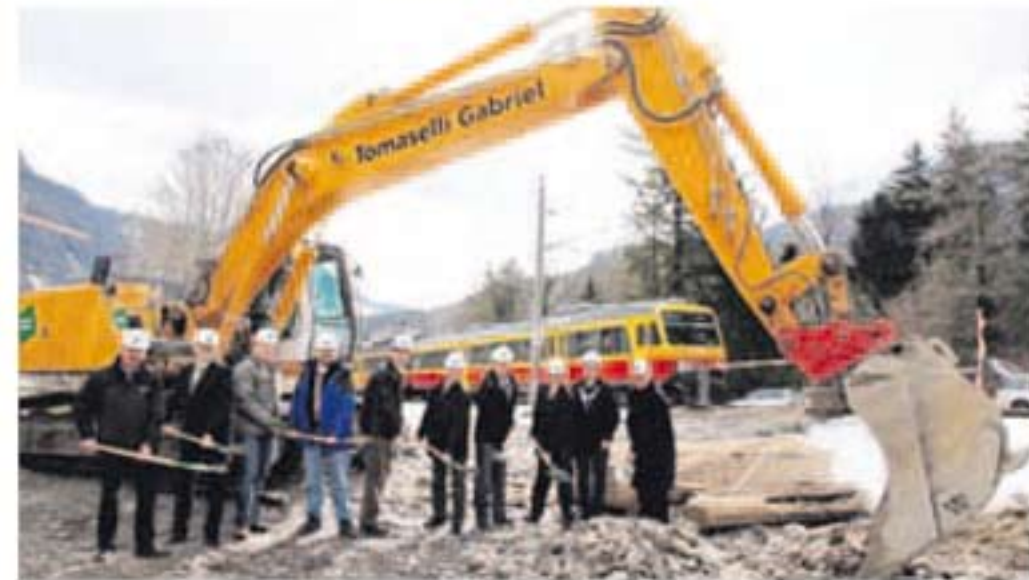
In Lorüns fand der Spatenstich für das Millionenprojekt der mbs statt.
