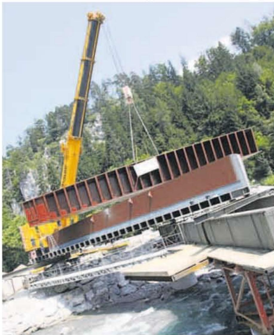
Mit einem 500-Tonnen-Mega-Kran wurde ein Teil der 340-Tonnen-Stahlbrücke millimetergenau versetzt. FOTO: MEZNAR-MEDIA.COM
