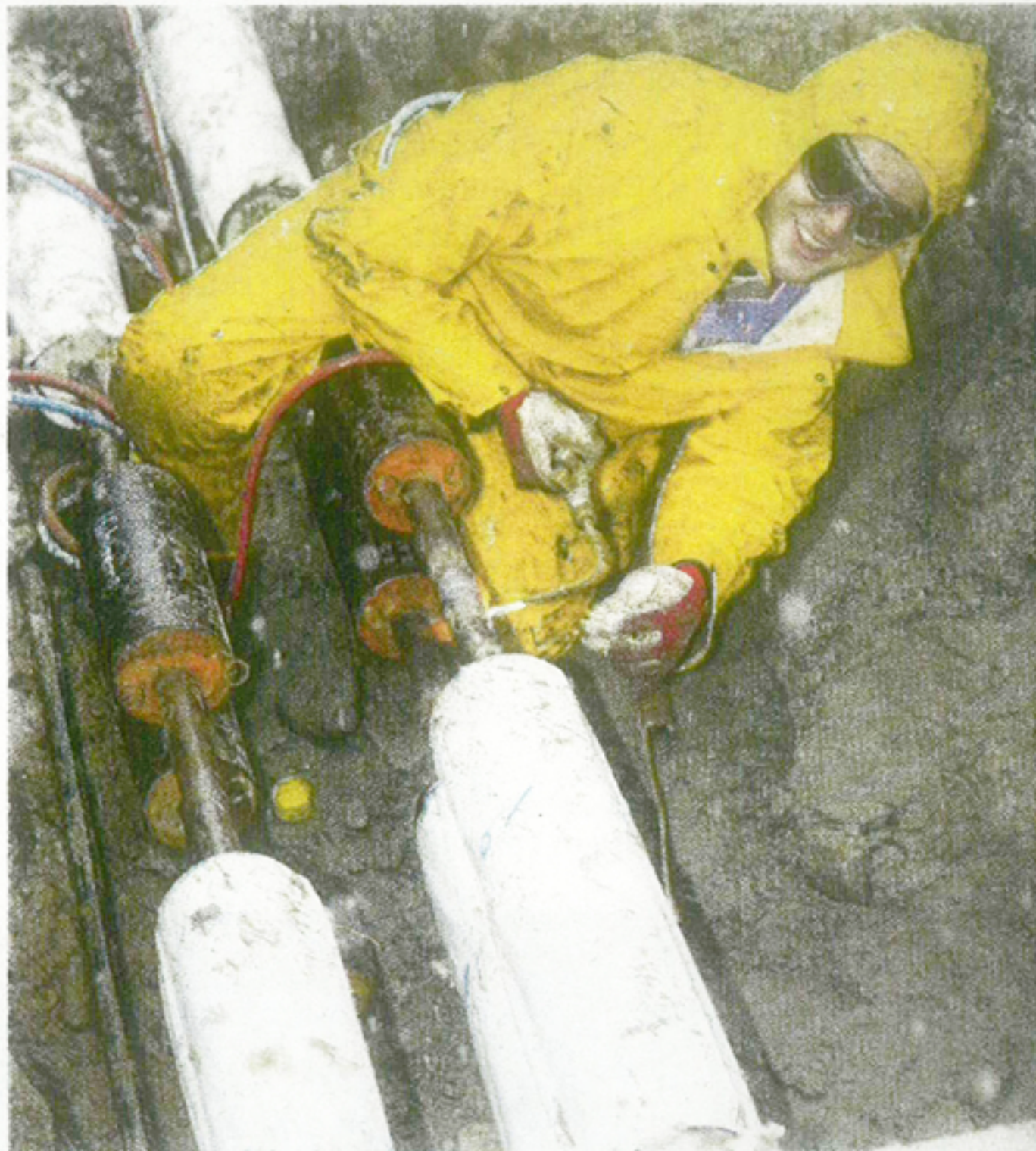
Bei der Verlegung der Fernwärme-Leitungen für die neue Busgarage wurde erstmals das Rohrfrost-Verfahren angewendet.
