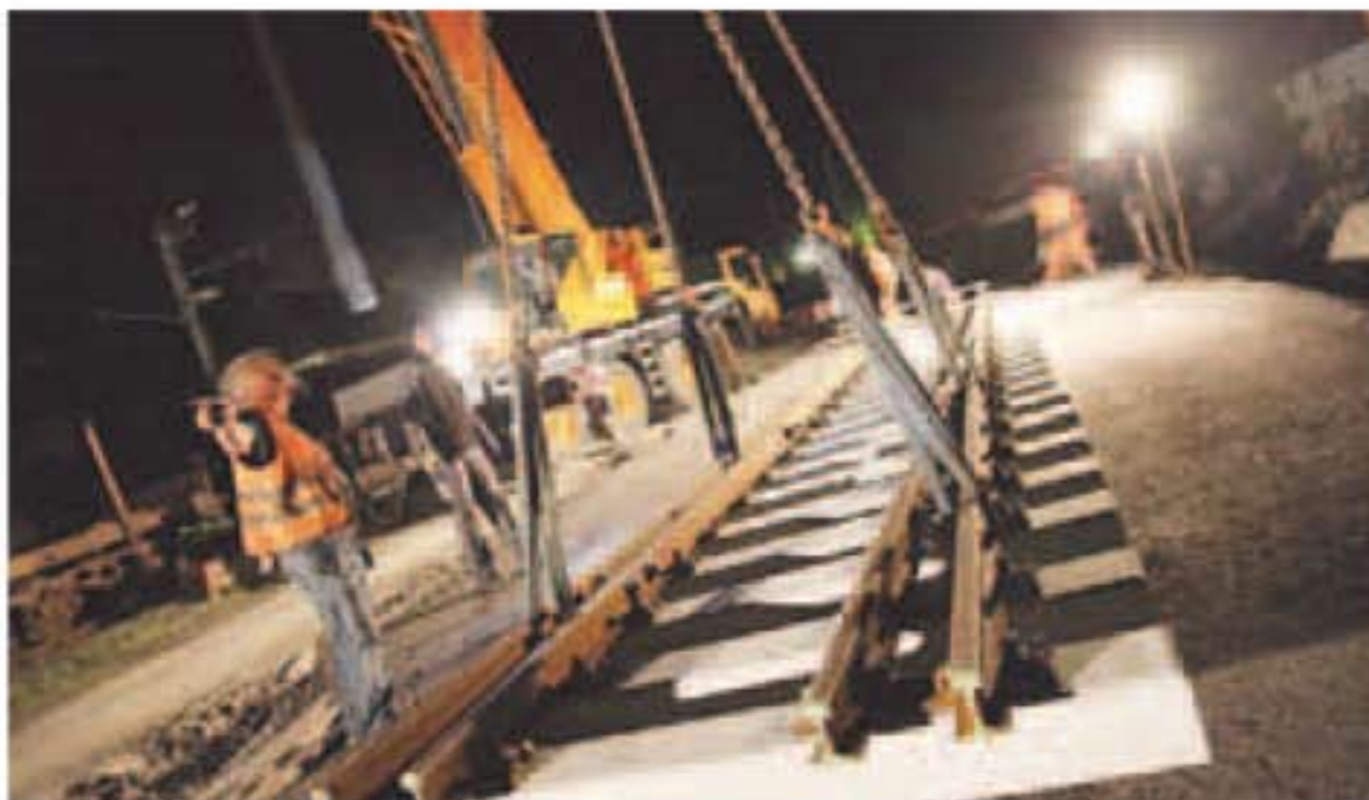
Spektakulärer Nachteinsatz beim mbs-Trassenneubau in Lorüns.
