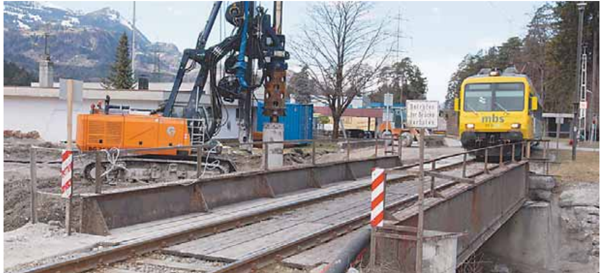
Die Bauarbeiten beim Trassenneubau der Montafonerbahn in Lorüns laufen auf Hochtouren.
