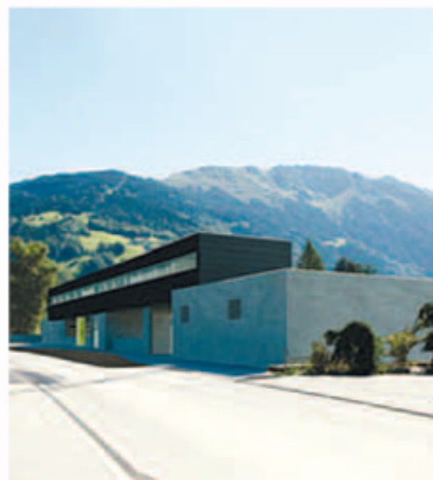
Zweckmäßig und modern – so wird die neue mbs-Bus-zentrale in Schruns.
