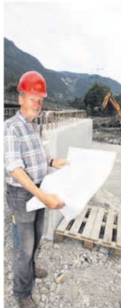
Neue Radwegbrücke an der Alfenzmündung ist im Aufbau. FOTO: MEZ
