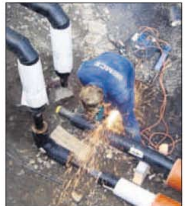
Auch die letzten Schweißarbeiten sind abgeschlossen.
