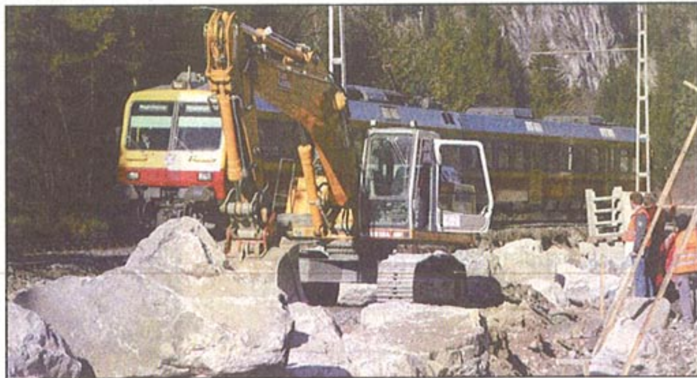
Reger Betrieb herrscht auf der Baustelle der neuen Trasse für die Montafonerbahn.
