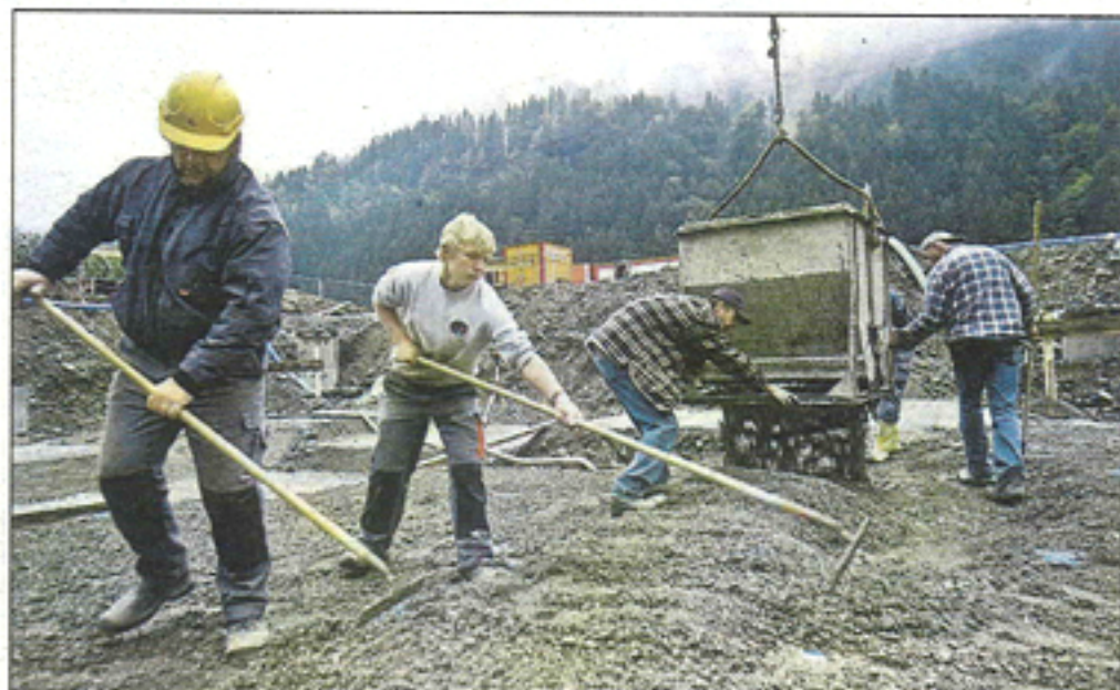
Wichtige Betonierarbeiten beim Naturwärmeheizwerk Montafon haben begonnen. (Foto: huber-images)
