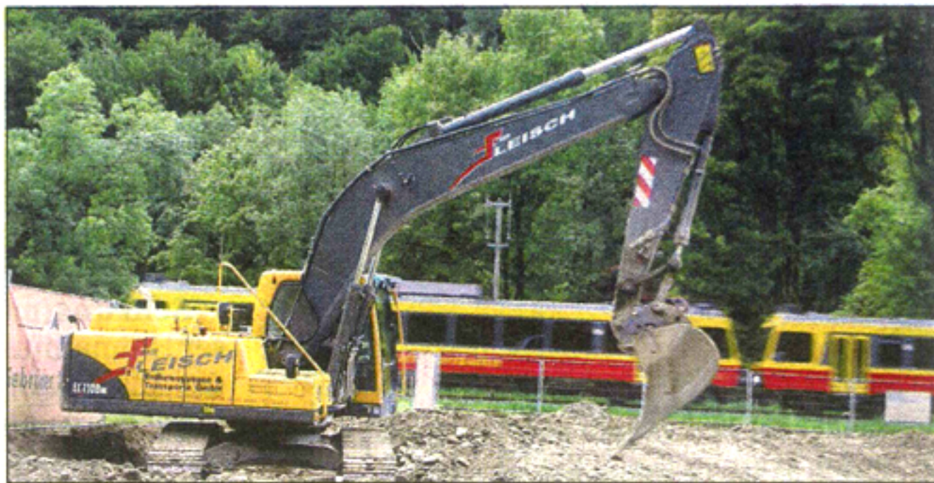
Die Arbeiten für das Naturheizkraftwerk Montafon laufen auf Hochtouren.
