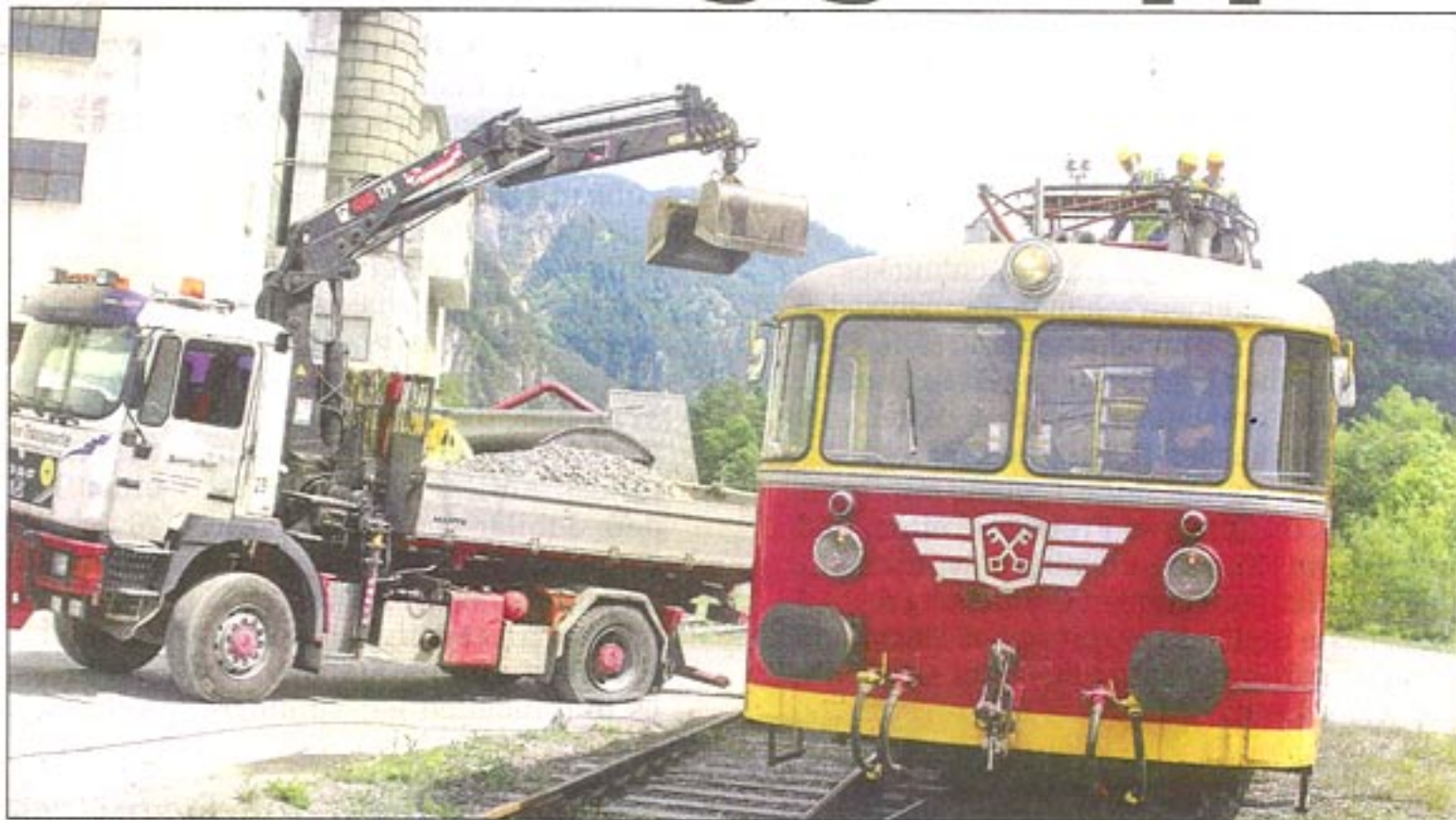
Mit dem ausgefahrenen Ladekran in die 15.000-Volt-Fahrleitung der Montafonerbahn.
