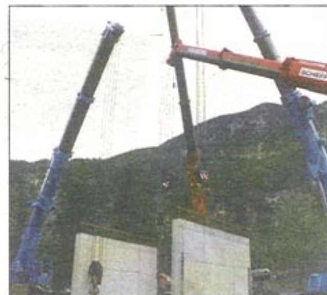
Spezialeinsatz von den größten Mobilkränen des Landes beim Trassenneubau der Montafonerbahn.
